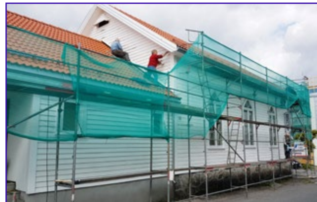
Utvendig maling blir utført på dugnad.
