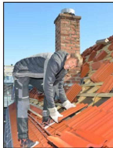
Byggmester Ronny Olsen har utført restaureringsarbeidet.
